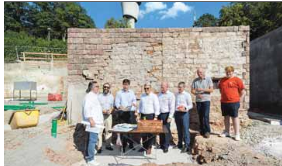
Auf dem Königstuhl legten gestern den Grundstein für das neue Restaurant-Hotel (v.l.): Architekt Ralph Flum, Miteigentümer Lionel Berger, Baubürgermeister Jürgen Odszuck, Eigentümer Wolfgang Scheidtweiler, Michael Jäger (Stadtwerke), Dieter Theilacker (Sparkasse), Architekt Hans-Jörg Maier und Maximilian Mouhlen (Märchenparadies). Foto: Rothe
