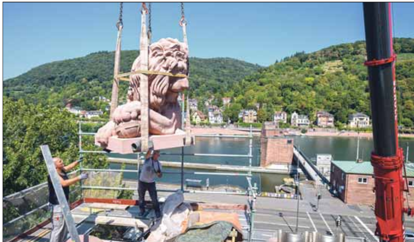
In je drei Teile geschnitten kehrten die beiden liegenden Löwen auf die Attika des Karlstores zurück und wurden dort zusammengefügt. Es sind Kopien der Originale aus dem späten 18. Jahrhundert, deren Oberflächen zu sehr zerstört waren. Fotos: Philipp Rothe
